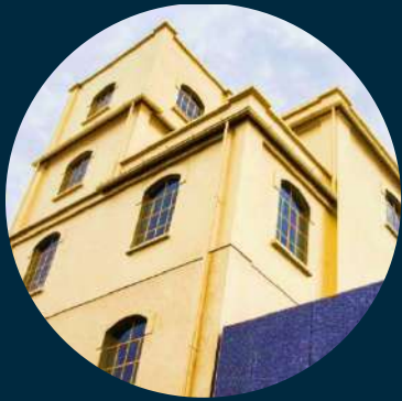
Fondazione PRADA Metro “yellow-line” “Lodi T.I.B.B.”
